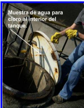
Muestra de agua para cloro al interior del tanque.
